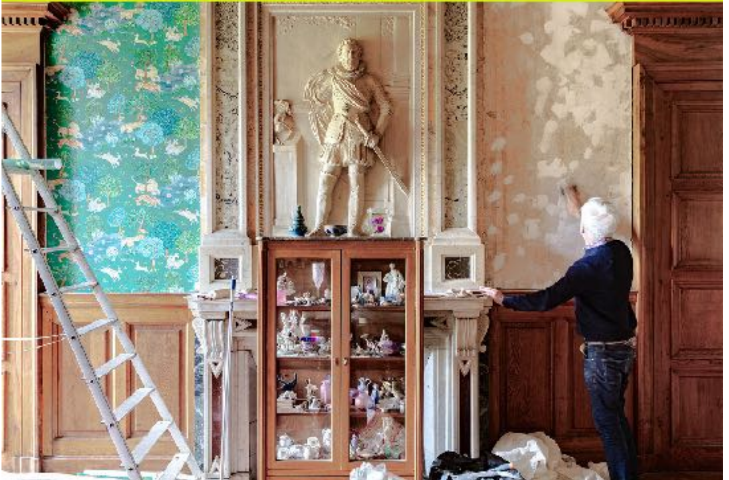
Rolland de Saint Seine en pleine rénovation au château de Longecourt en plaine
